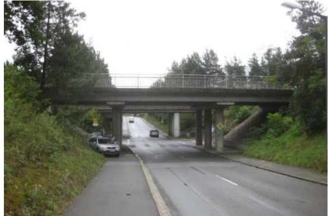
St 2241 Unterf. Mittelbügweg und LAU 15
