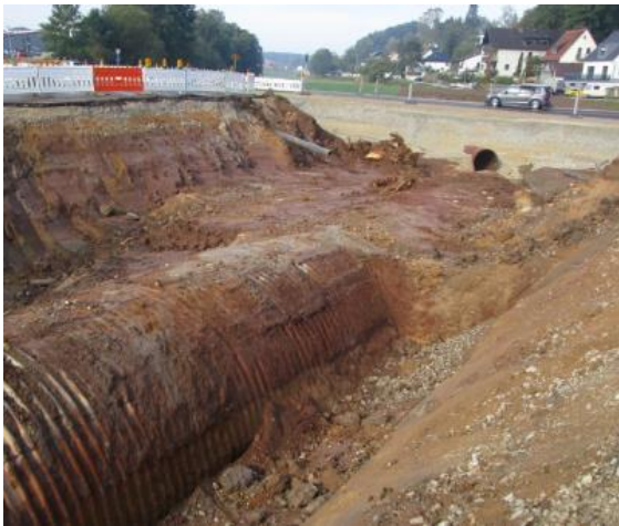
Freilegung alter Durchlass, im Hintergrund bauzeitliche Umfahrung
