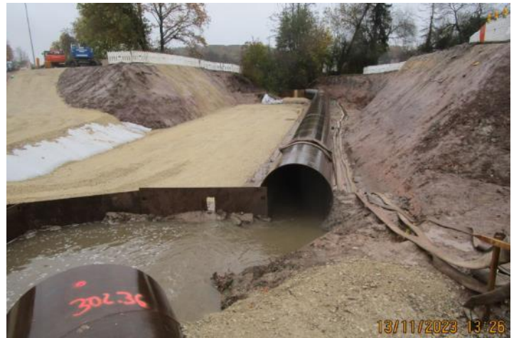
Bauzeitlich verlegter Reichenbach und vorbereitete Gründung für neuen Durchlass
