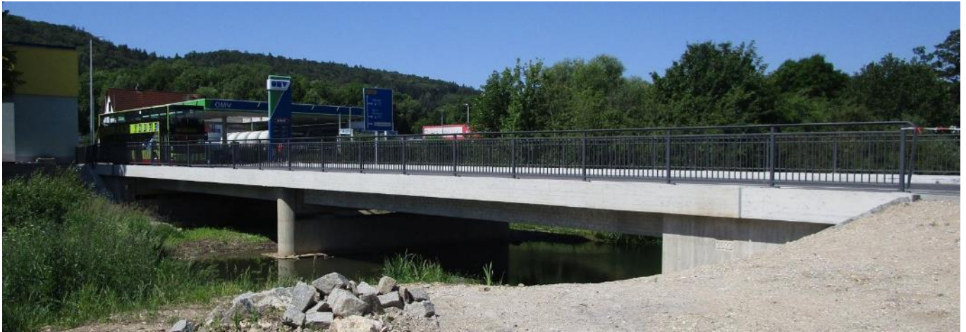
St 2336, Schwarzachbrücke Greding
